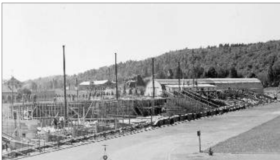
Arbetet på läktarbygget i full gång. I bakgrunden syns den nya tennishallen.
